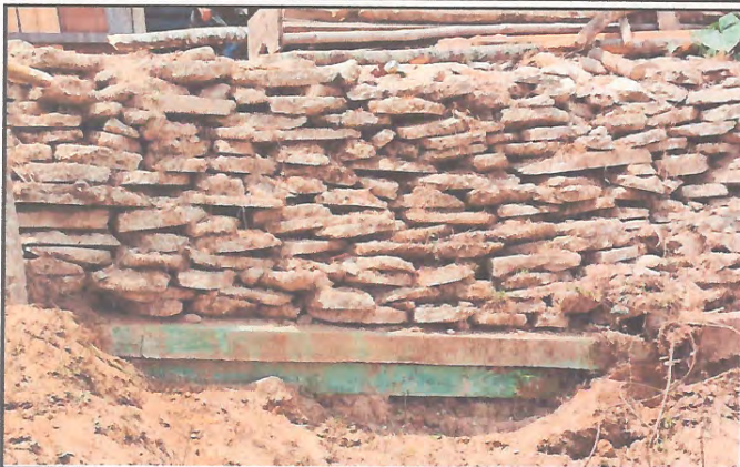
Foto 1: Se remoja el extremo 1 del muro en el lado oriente.
