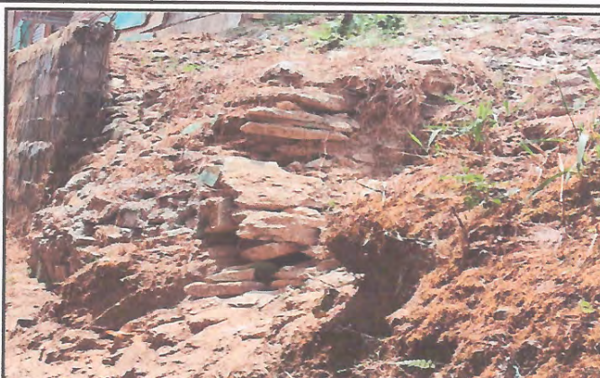
Foto 2: Remozar el extremo 2 del muro en el lado poniente.
