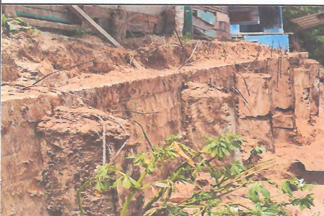
Foto 3: Mejoramiento de altura del muro de contención.
